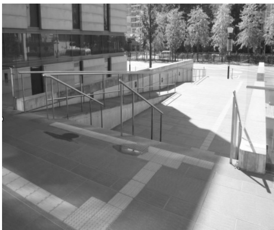
주출입구 전면 계단을 휠체어 사용자의 접근이 가능하도록 경사로(1/12 이하의 기울기)와 함께 설치한 좋은 예.
