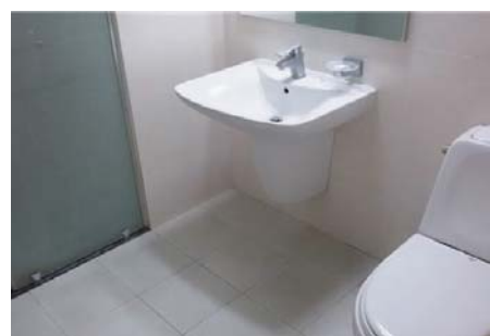
장애인 객실에 설치해야 하는 대변기의 손잡이 미설치.
